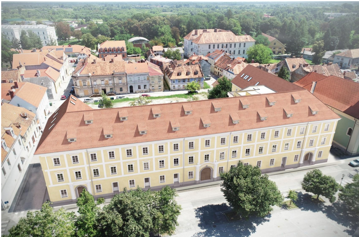
Zgrada centra kompetentnosti
